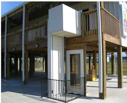
기존 시설을 개조 보수하여 배리어프리화 한 예. 동이 불편한 사람들을 위한 간이 열대베이터다. / 출처 위키피디아
